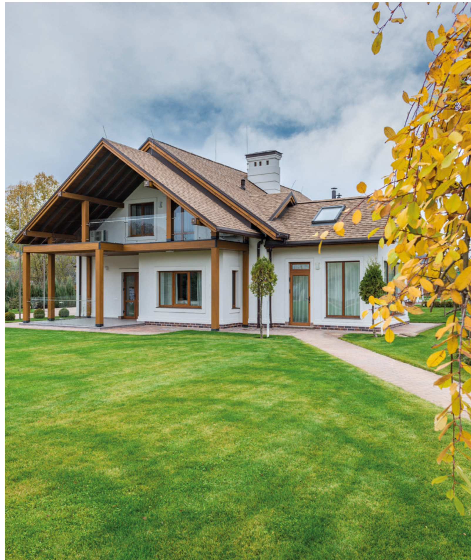
Souhlas s provedením ohlášené stavby i stavební povolení mají omezenou platnost, a to dva roky ode dne vydání. Foto redakce
